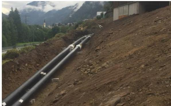
Bild: Abwärmeverbund Gaschurn-Partenen, Die Quelleitungen wurden entlang der Montafonerstraße verlegt.
